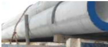
\* Antes de soltar las cadenas y/o eslingas se debe asegurar los postes con cuñas de acero y/o madera. Y Verificar el estado de las eslingas con las cuales se va a realizar la manipulación de la carga.
